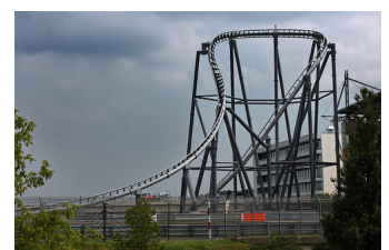
Der Nürburgring im Umbau, Foto: flickr.com, mjohn2101
